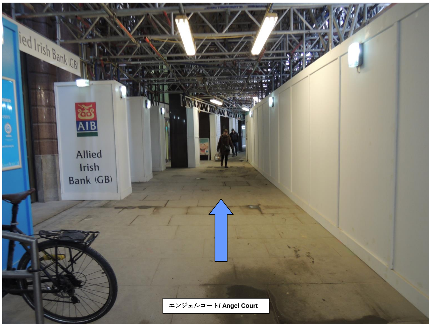
工事中の Angel Court を突き当たりまで進む
